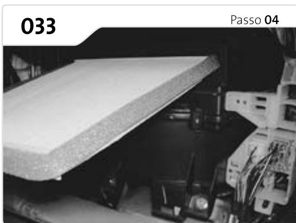
Instale o filtro. Utilize a tampa recortada para fechar o buraco. Faça o acabamento com massa de calafetar, fita adesiva, isolante ou silver tape.
